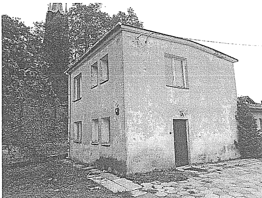
Fot.4 Elewacja zachodnia i północna
